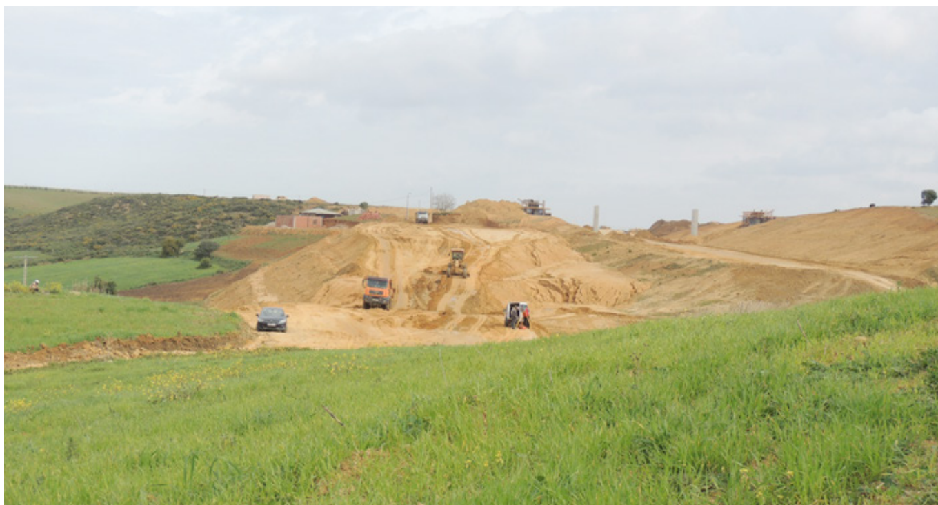
Construction de la ligne de train à grande vitesse traversant Tendafel (photo © Tim Dodman).
