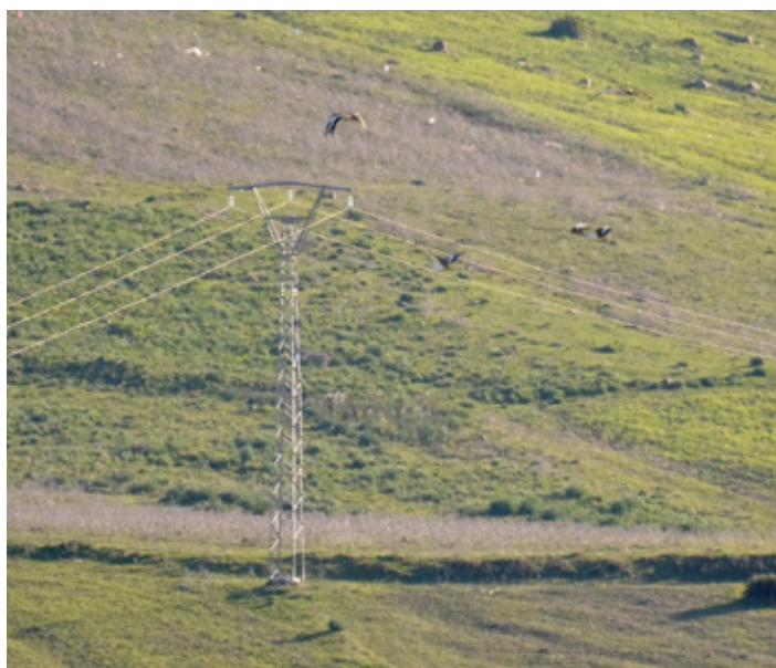
Grandes outardes volant au-dessus d'une ligne électrique à Araoua ; cette ligne électrique traverse une vallée que les outardes doivent emprunter fréquemment (photo © Rachid El Khamlichi).
