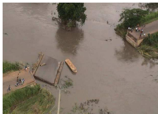
Figure 3 : Rupture du pont sur la route nationale N°1 à AMAKPAPE suite aux inondations d'août 2008
