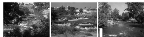
Fotografia 3.1 – Exemplos de acidentes geológicos e estrangulamentos que interferem/ condicionam o escoamento (Menongue)
