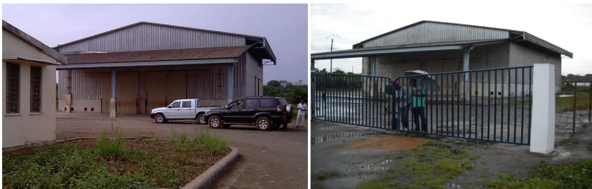
Figure 7: (a) Magasin KR2 à Edéa avant réhabilitation (PNM, 2012) (b) après réhabilitation comme Infrastructure de Stockage Temporaire en attendant leur élimination
