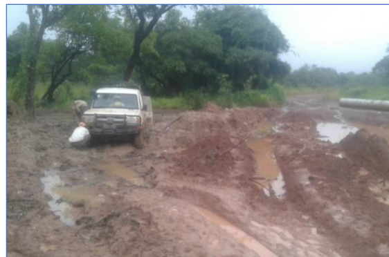
Photo 2: Mauvais état de la route nationale n° 1, à quelques kilomètres de Kyabo (province de la Lualaba), pour relier le territoire de Bukama (province du Haut-Lomami), République Démocratique du Congo © FAO/Cyrille Kapuma Balasey/MINIPEL
