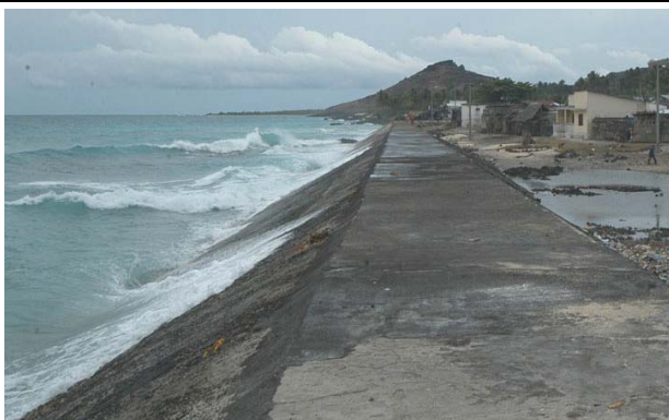
Figure 16 : Débordement de la digue de protection du village de Bangoi-Kouni (Nord de Gde-Comore) par les houles et inondation de deux quartiers (1 er mars 2006).
