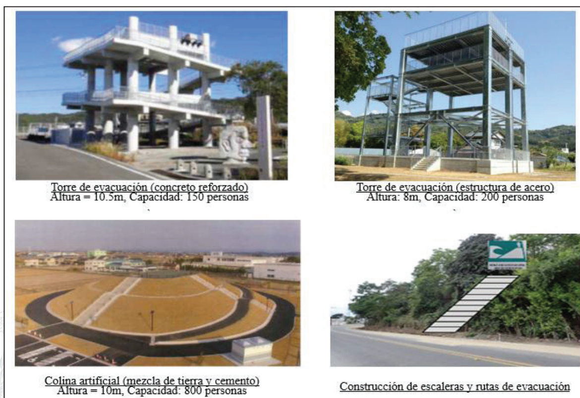
Ilustración 32. Ejemplos de torre de evacuación, escaleras, rutas de evacuación y colina artificial
