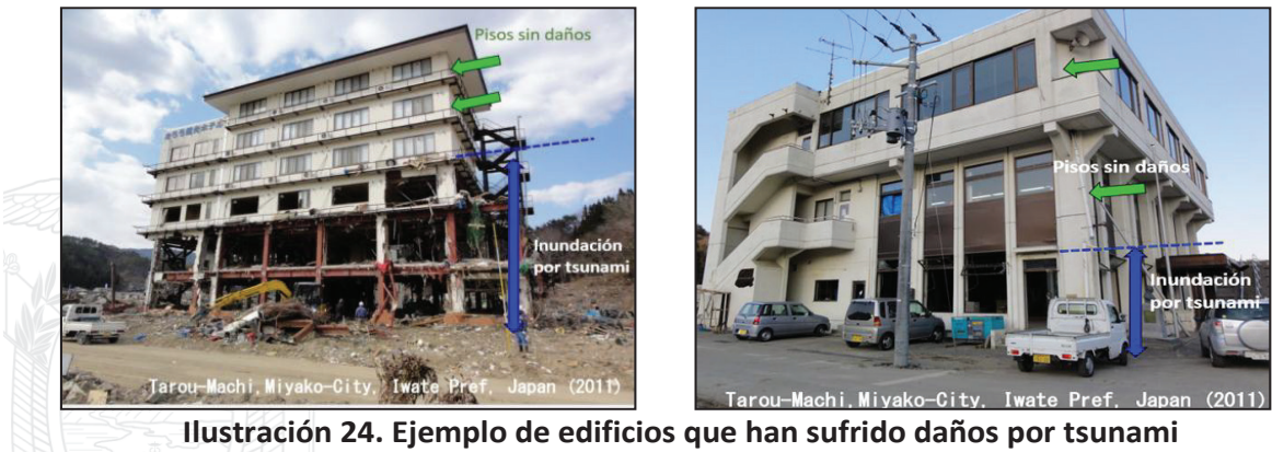
Ilustración 23. Estudio sobre los pisos con posibilidad para evacuación vertical ante tsunami
