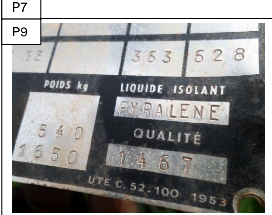
Photos P5, P6, P7, P8, P9 et P10 : Inspection de postes de transformateurs à PCB
