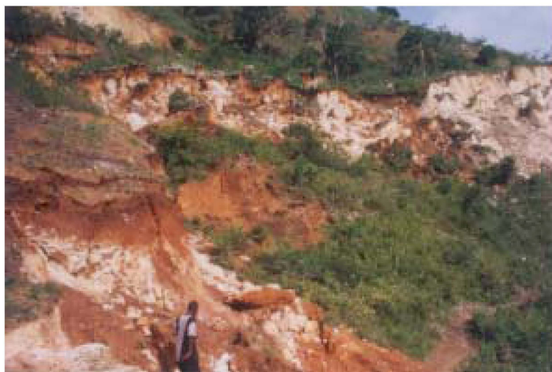
Effondrement à Gros Morne
