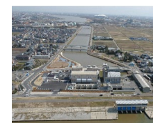
排水機場の整備
