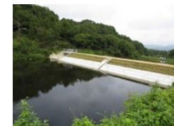
老朽化したため池の 全面改修
