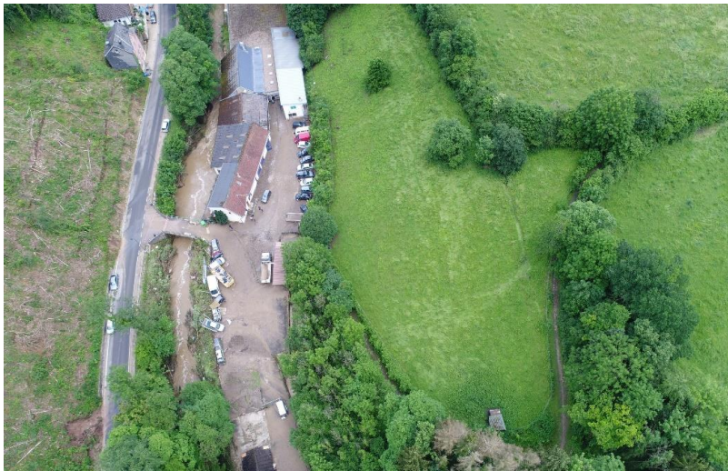
Abbildung 43: Schäden in Grundhof
