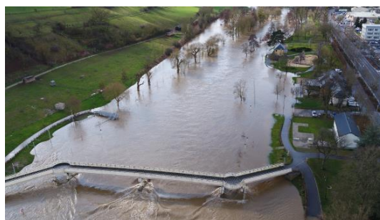
Abbildung 63: Schlauchwehr in Diekirch bei Hochwasser (AGE)
