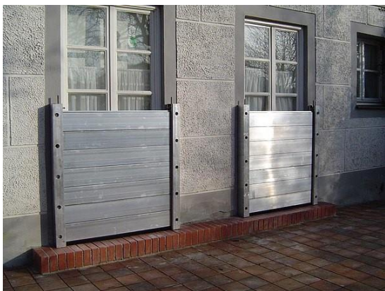
Abbildung 25: Mobiles Dammbalkenschutzsystem. Quelle: IBS GmbH
