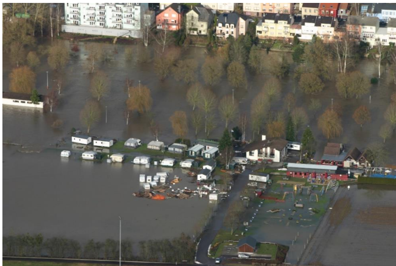
Abbildung 2: Hochwasserschäden in Diekirch an der Sauer (2011, AGE)
