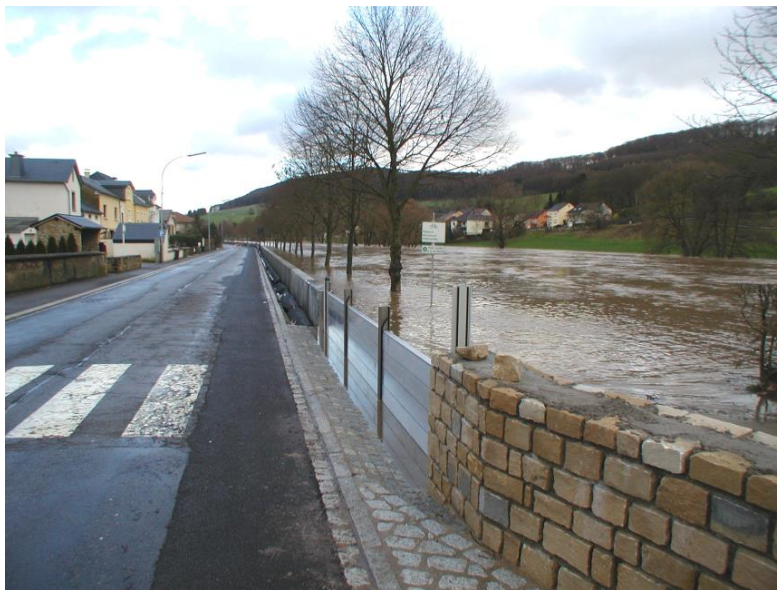
Abbildung 59: Hochwasserschutzmauer in Ingeldorf (AGE)
