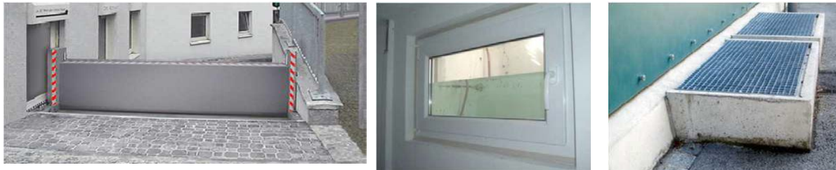
Abbildung 24: Beispiele von festen (aber beweglichen) Objektschutzmaßnahmen
