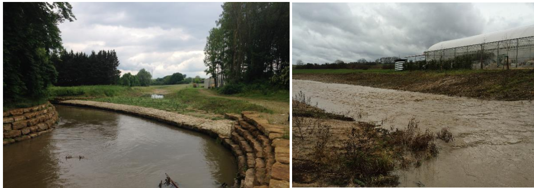
Abbildung 67: Hochwasserbypass der Gander in Mondorf-les-Bains
