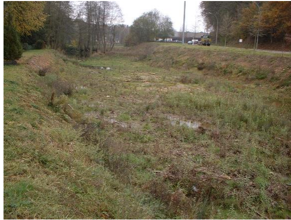
Abbildung 68: Hochwasserbypass an der Attert in Bissen (AGE)
