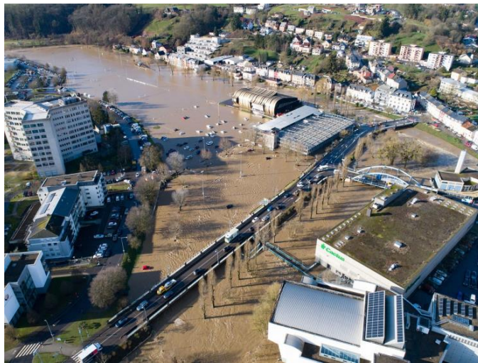
Abbildung 24: Überschwemmung des Parkplatzes "Däichwissen" in Ettelbrück (wort.lu)
