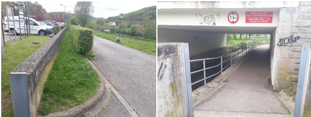
Abbildung 64: Hochwasserschutzmauer in Echternach (AGE)
