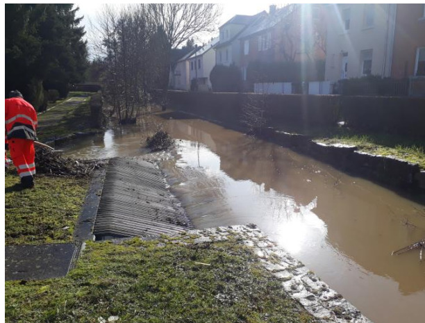
Abbildung 65: Umleitung des Osweilerbaches bei Hochwasser (AGE)
