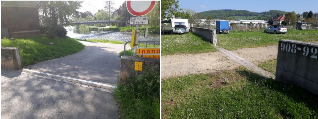
Abbildung 61: Hochwasserschutzmauer in Diekirch (AGE)
