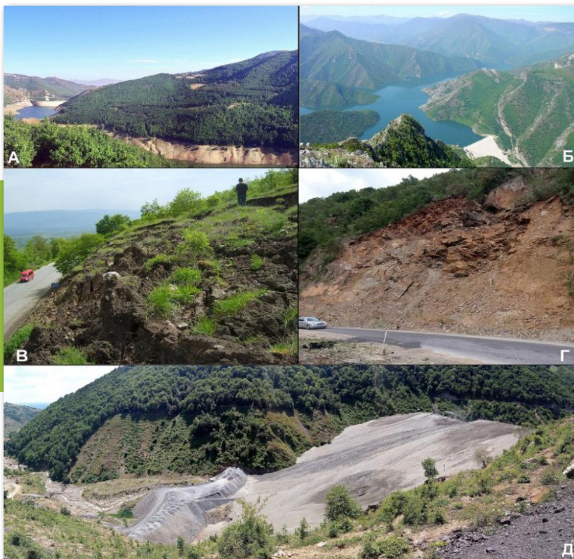
Слика 41. Закани врз геодиверзитетот преку: А. засилена ерозија долж новоформирана крајбрежна зона (акумулација Глажња); Б. потопување на клисурски и кањонски делови со карстен релјеф (акумулација Козјак); В. активирање на свлечишта на засеци кај с. Страцин; Г. активирање на одрони на изразито засечени шкрилци кај с. Калиманци; Д. формирање на јаловиште во долината на Каменичка Река.
