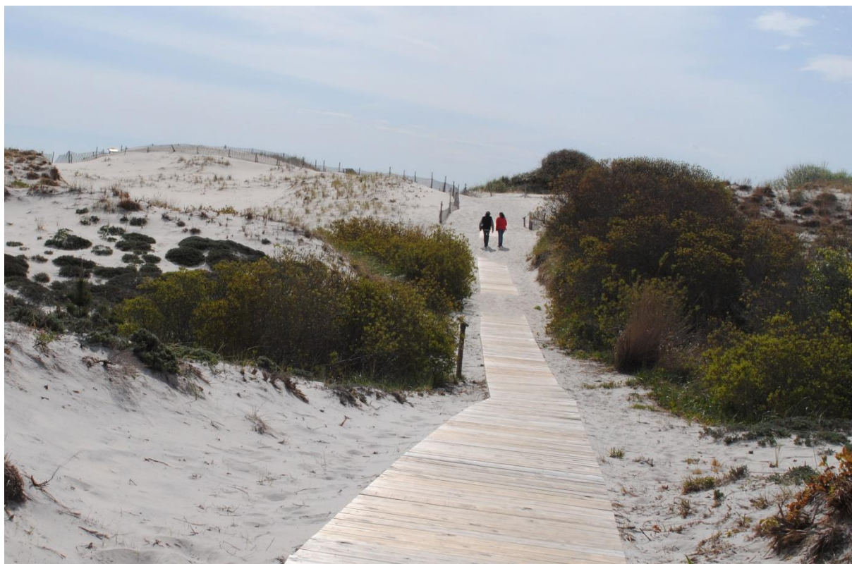
Passages de franchissement du cordon dunaire aménagés et accompagnés de dispositifs de protection mécanique (New Jersey, USA)
