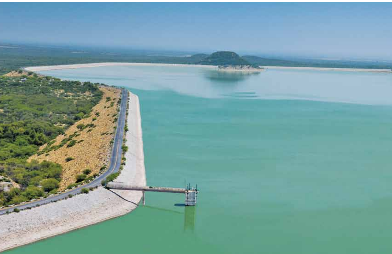
Presa Cerro Prieto, Nuevo León.
