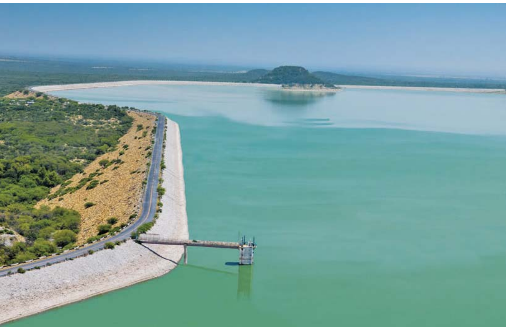
Cerro Prieto Dam, Nuevo León.
