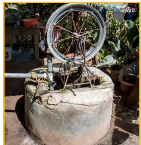
Foto 20: Pozo excavado con bomba de mecate
