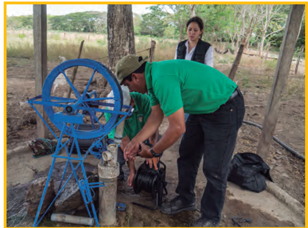
Foto 16: Técnicos municipales de Juigalpa midiendo nivel de agua subterránea en pozo perforado con bomba de mecate
