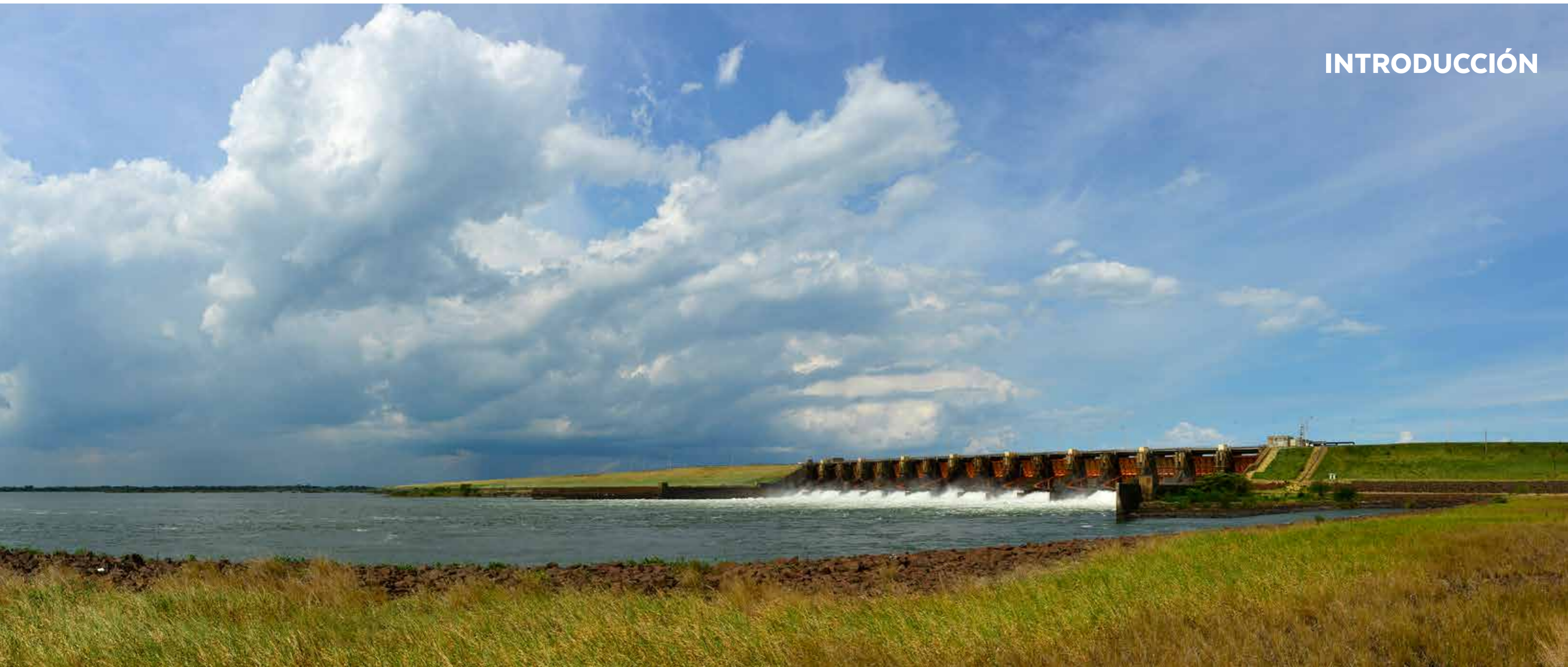
Vista panorámica del vertedero de Aña Cuá. Yacyretá, Departamento de Misiones.
