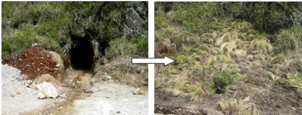
Foto N° 3. Bocamina antes y después, rellenada y revegetada. Colquirrumi
