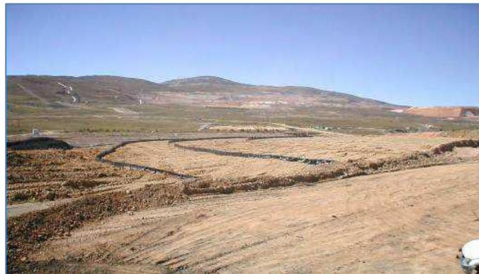
Foto N° 6. Aplicación de la cerca de sedimento
