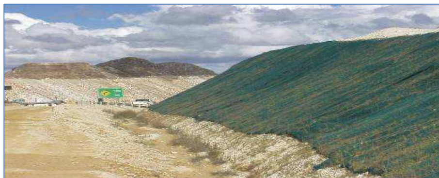
Foto N° 3. Mantas para el control de la erosión
