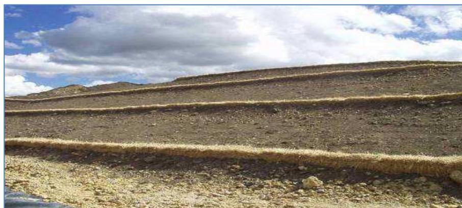
Foto N° 5. Aplicación de pacas de paja
