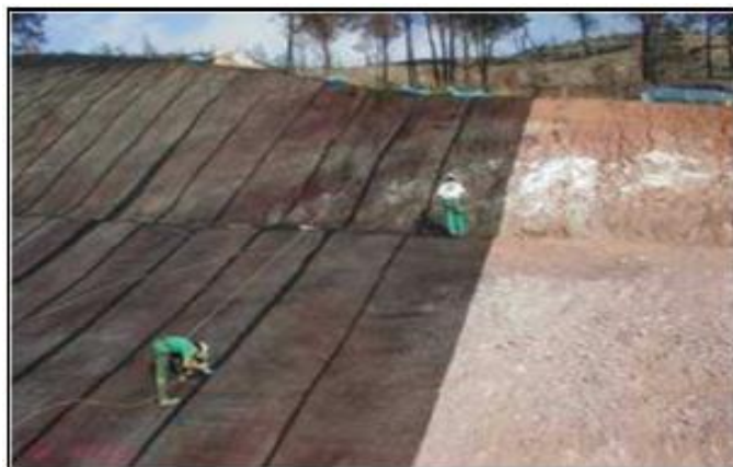
Foto N° 12. Recubrimiento de un área con geomembrana
