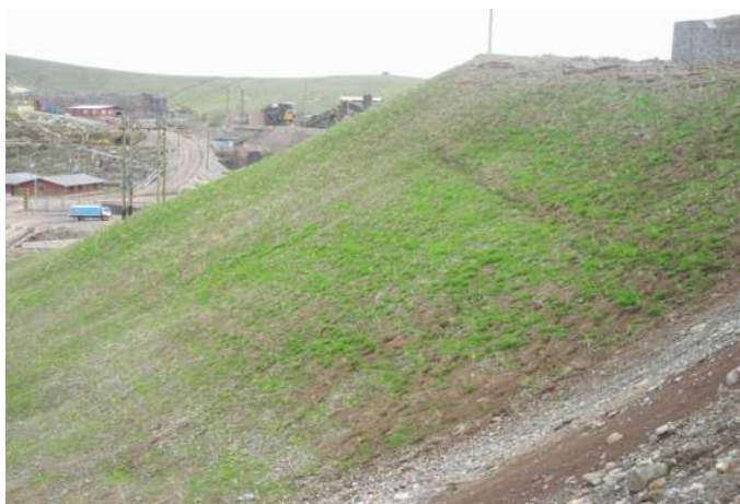
Foto N° 7. Cierre y revegetación del depósito de relaves. Colquijirca
