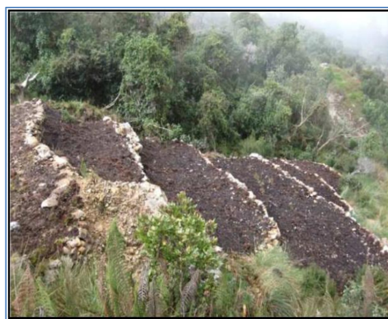
Foto N° 13. Rehabilitación de plataformas de perforación. La Zanja
