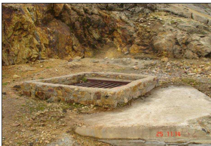
Foto N° 5. Cierre de chimeneas
