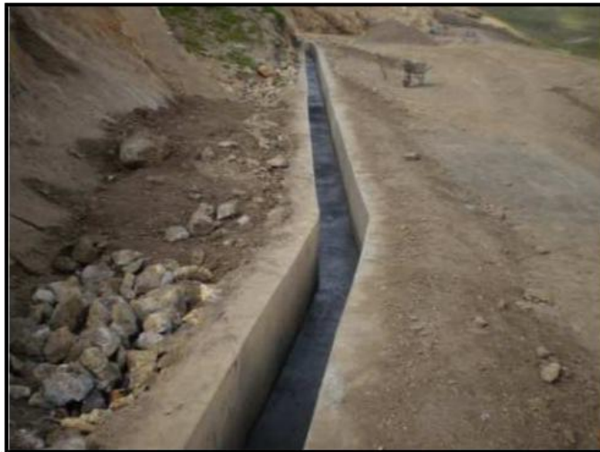
Foto N° 10. Canales de coronación emboquillados de piedra
