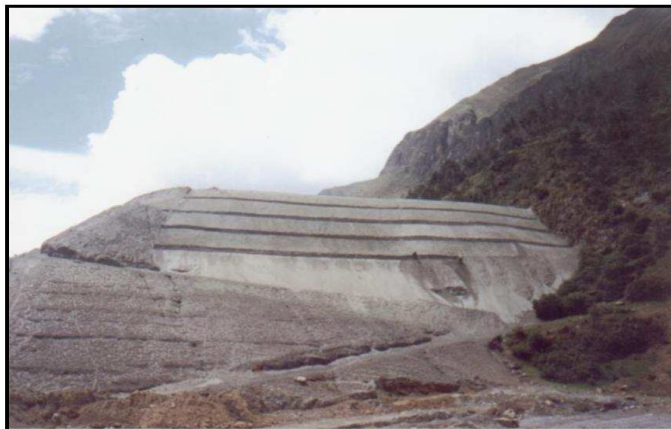
Foto N° 14. Preparación del talud de una relavera 3 400 msnm
