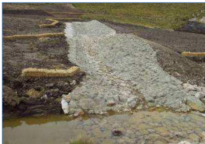
Foto N° 1. Canal con rip-rap con lechada de concreto
