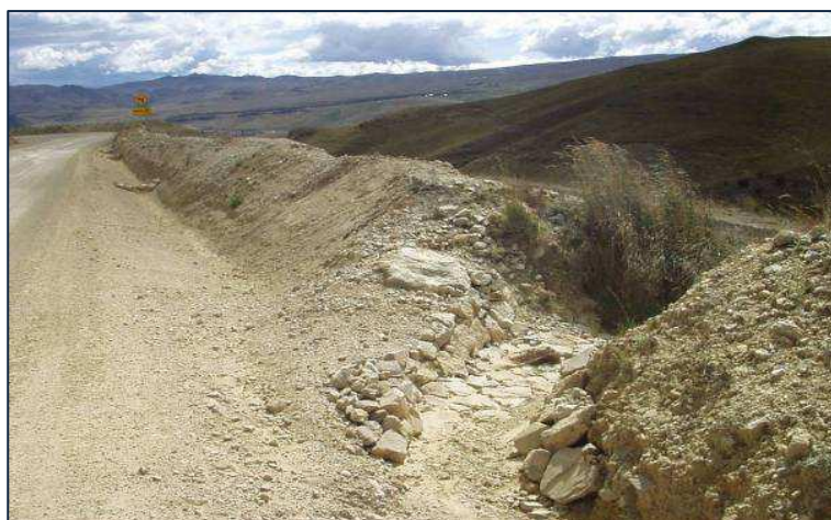
Foto N° 10. Abertura de Berma
