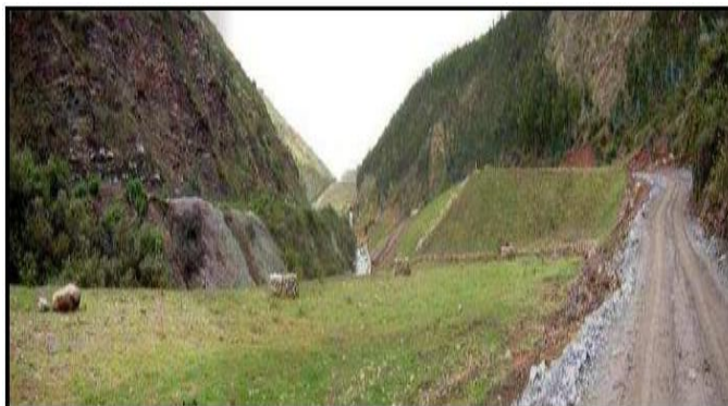
Foto N° 13. Revegetación de una cancha de relaves
