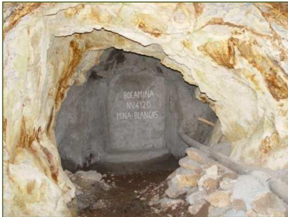
Foto N° 1. Cierre de bocamina con drenaje, Julcani
