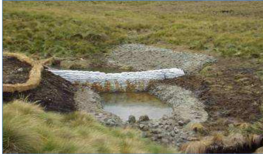
Foto N° 4. Estructuras de sacos con concreto
