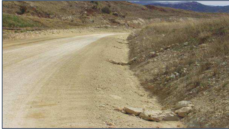
Foto N° 8. Drenaje de camino
