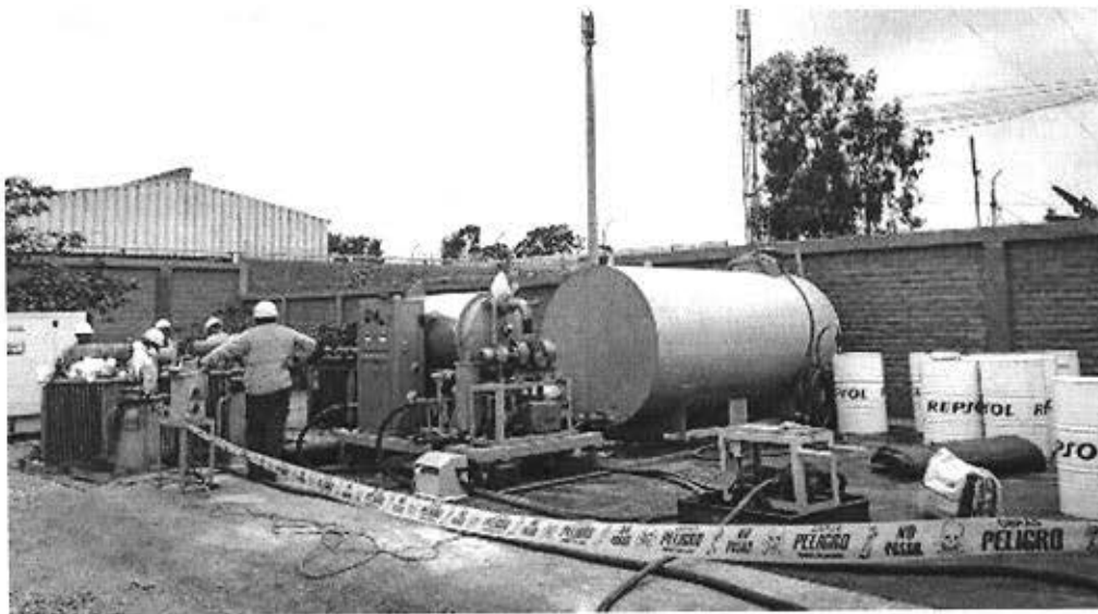
Figura N° 29: Equipo utilizado para el proceso de retrolenado
