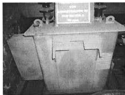
Figura Nº 10: Etiqueta en equipo contaminado con PCB - PROYECTO PCB UNIDO/DIGESA
