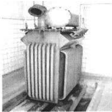
Figura N° 12: Transformadores de subestaciones presentan pérdidas y manchas de aceite tanto en equipos como en la instalación
