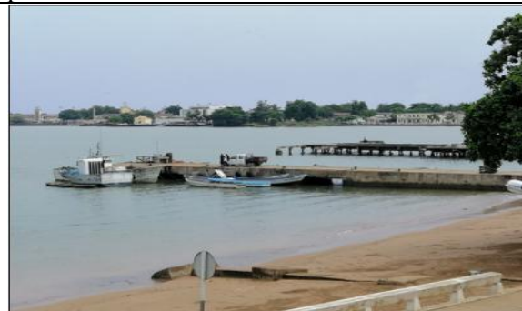
Figura 19. ilustrações relativas à ponte-cais da pesca semi-industrial em são tomé
