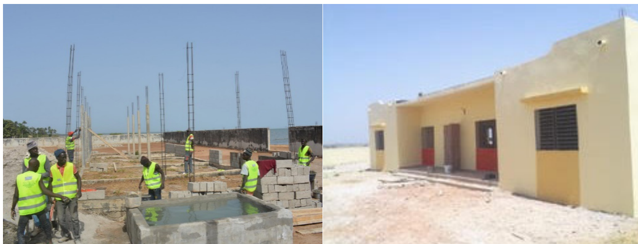
Figure 19 : Travaux du quai de Goudomp
