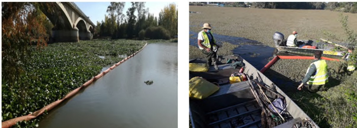
Fotografía 16. Barrera de contención para frenar la propagación del camalote ( Eichhornia crassipes ) en un tramo remansado del río Guadiana (izq.) y labores de retirada de helecho de agua ( Azolla spp.) en río Tajo (dcha.).
