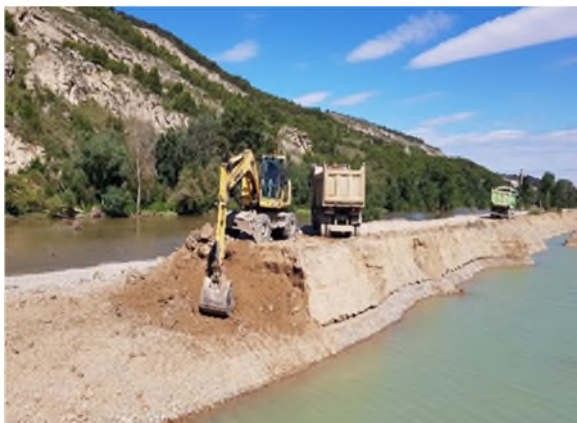
Fotografía 5. Medidas de mejora de las condiciones morfológicas. Eliminación de obras de defensa sin efectos significativos negativos sobre los usos del suelo y demolición de infraestructuras hidráulicas en desuso. Retranqueo de mota de tierra (izq.) y recuperación de la llanura de inundación con canal trenzado (dcha.), en el río Arga.
