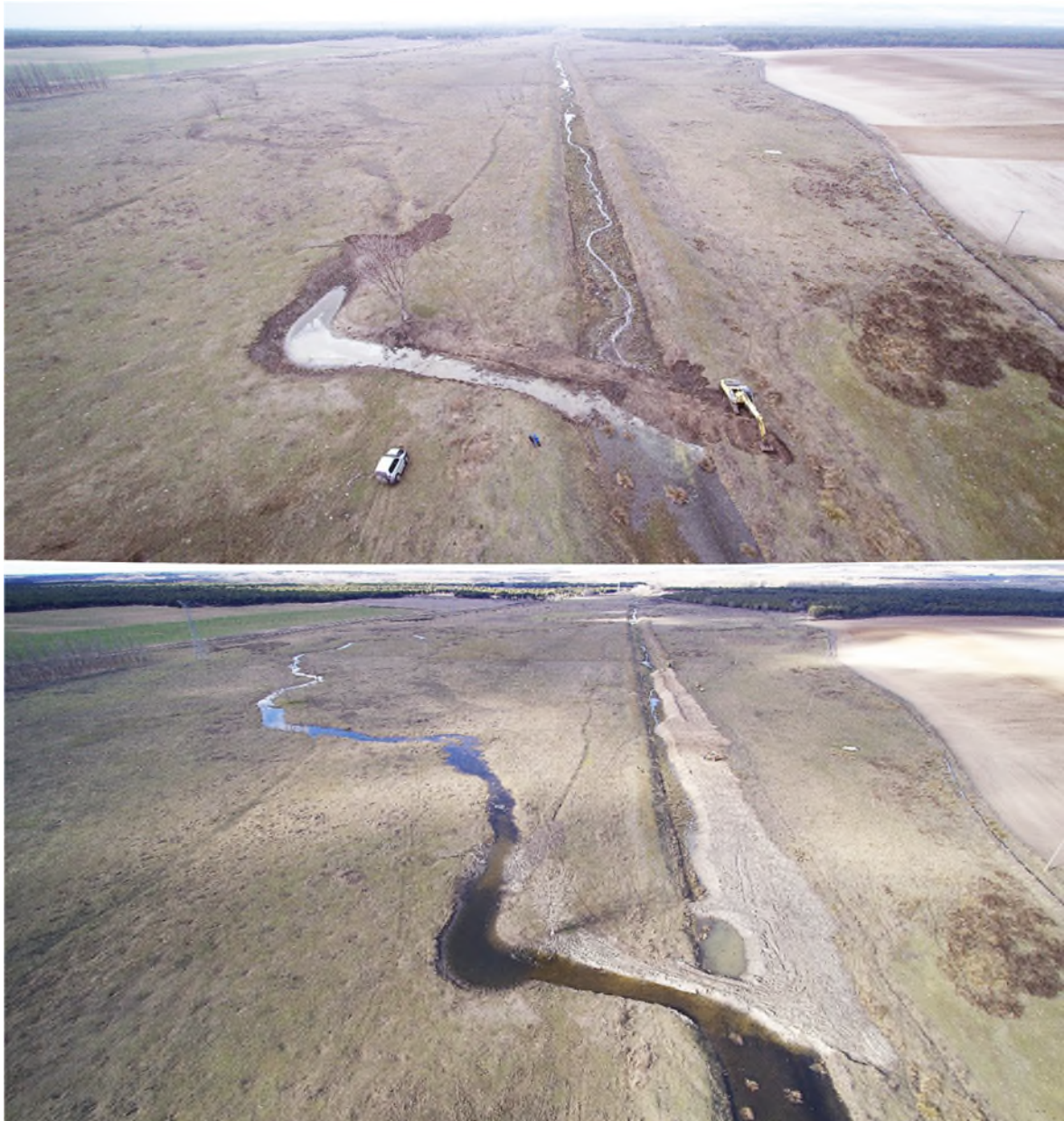
Fotografía 8. Actuación de recuperación del trazado natural en un tramo rectificado del río Zapardiel. Inicio de las obras (arriba) y conexión del trazado antiguo tras las obras (abajo).
