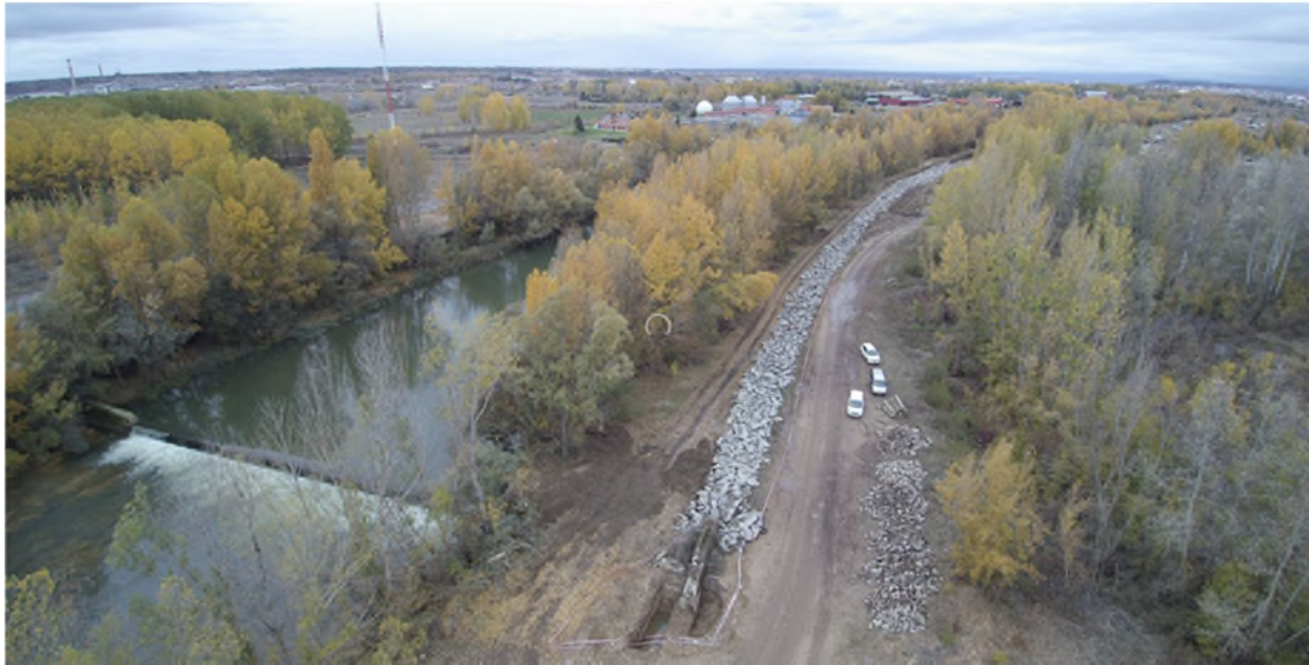
Fotografía 30. Recuperación del espacio fluvial mediante la demolición de mota de defensa en el río Bernesga.
