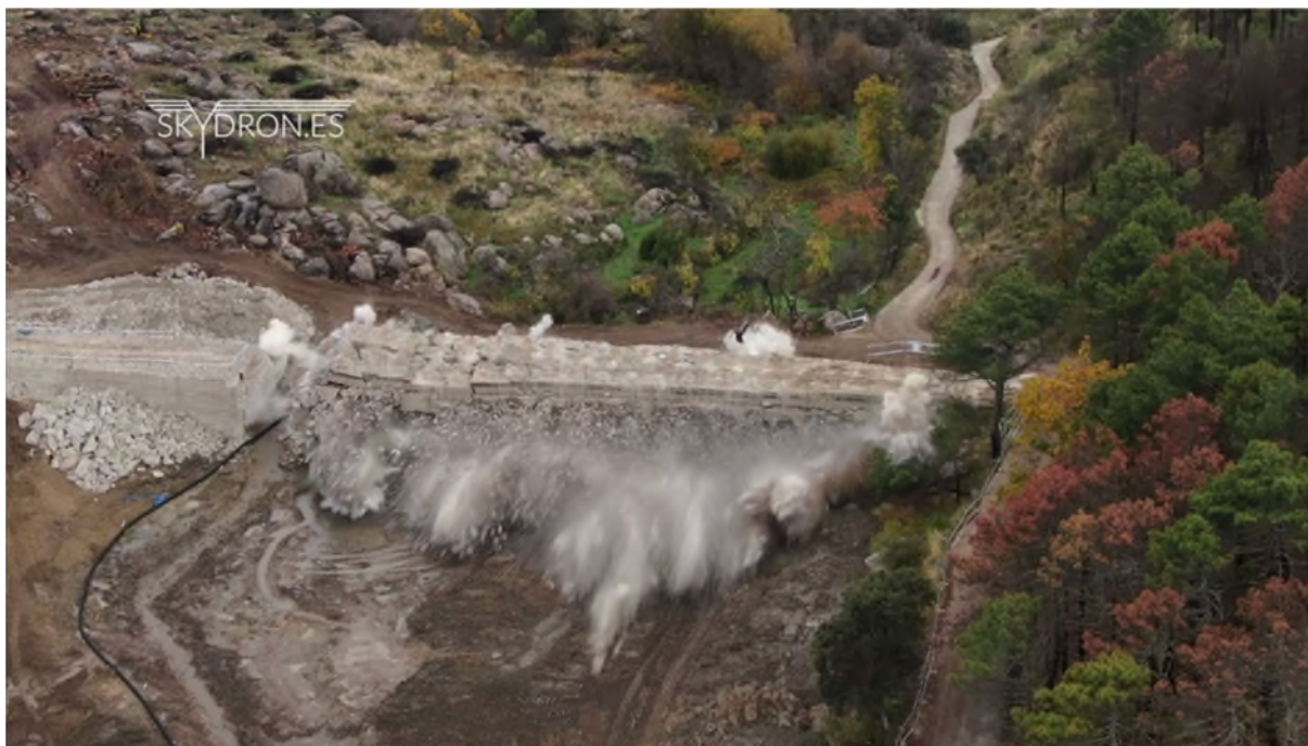
Fotografía 11. Demolición de la presa ‘La Alberca’ en Cenicientos (fuente: Canal de Isabel II, Comunidad de Madrid).
