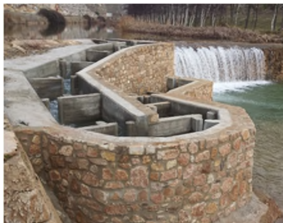
Fotografía 19. Alteración de la continuidad longitudinal. Permeabilización de azud en el río Ucero antes (izq.) y después (dcha.) de la construcción de una escala de peces.
