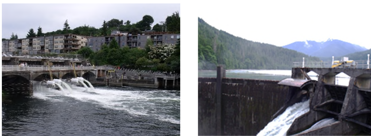
Fotografía 2. Permeabilización para la migración piscícola de una compuerta en Puget Sound, Seattle (izq.) y detalle de la presa de Glines Canyon previo a su demolición. Río Elwha, Washington (dcha.)
