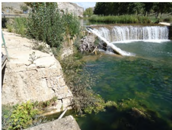
Fotografía 19. Alteración de la continuidad longitudinal. Permeabilización de azud en el río Ucero antes (izq.) y después (dcha.) de la construcción de una escala de peces.
