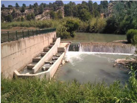
Fotografía 9. Mejora de la continuidad longitudinal de las poblaciones piscícolas mediante la permeabilización de azudes y presas. Escala de artesas de hendidura vertical en el río Segura (izq.) y paso específico para anguilas en estación de aforo del río Guadamar (dcha.).
