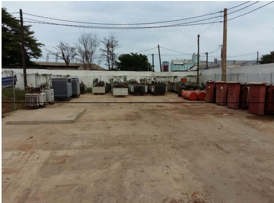
Figure 3: Site de stockage temporaire des PCB au magasin central de la CEET
