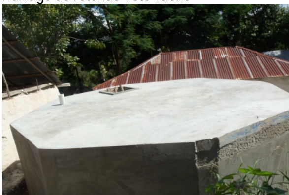
Travaux de construction d'une citerne à Caluc
