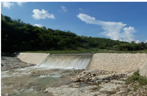
Barrage de retenue Tête vache
