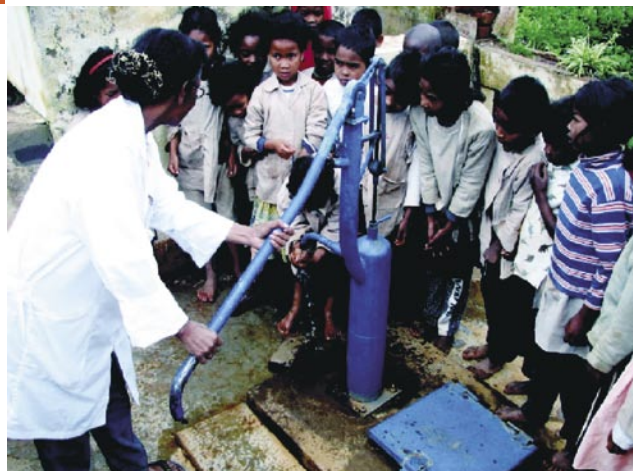
Adduction d'eau potable
