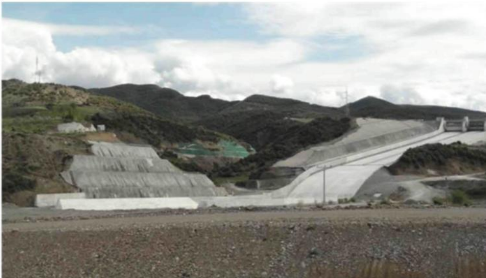
Figura 9: Diga e Banjës – Tregon shkarkuesin nga përmbytjet dhe bankinat mbrojtëse ne bjeftin e poshtëm
