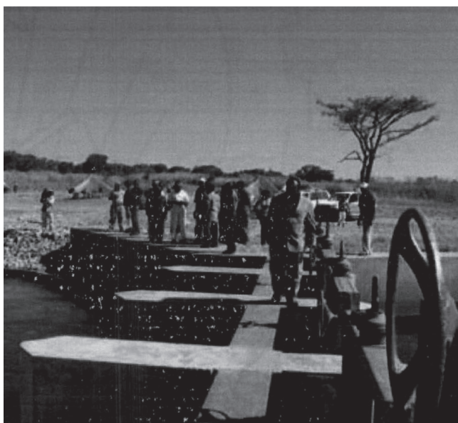
Obras hidráulicas em Menongue, Angola
