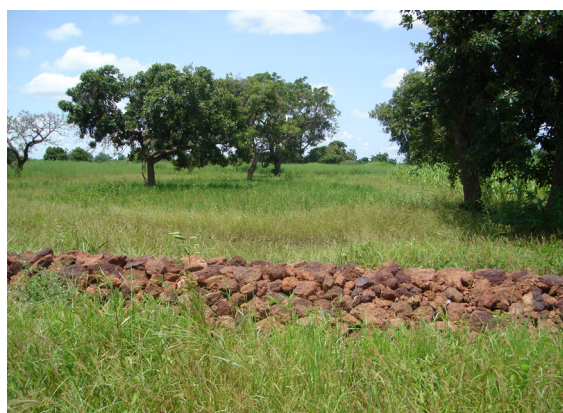
Mise en place d'une digue filtrante à gauche dans la commune de Absouya (Photo : CPP)
