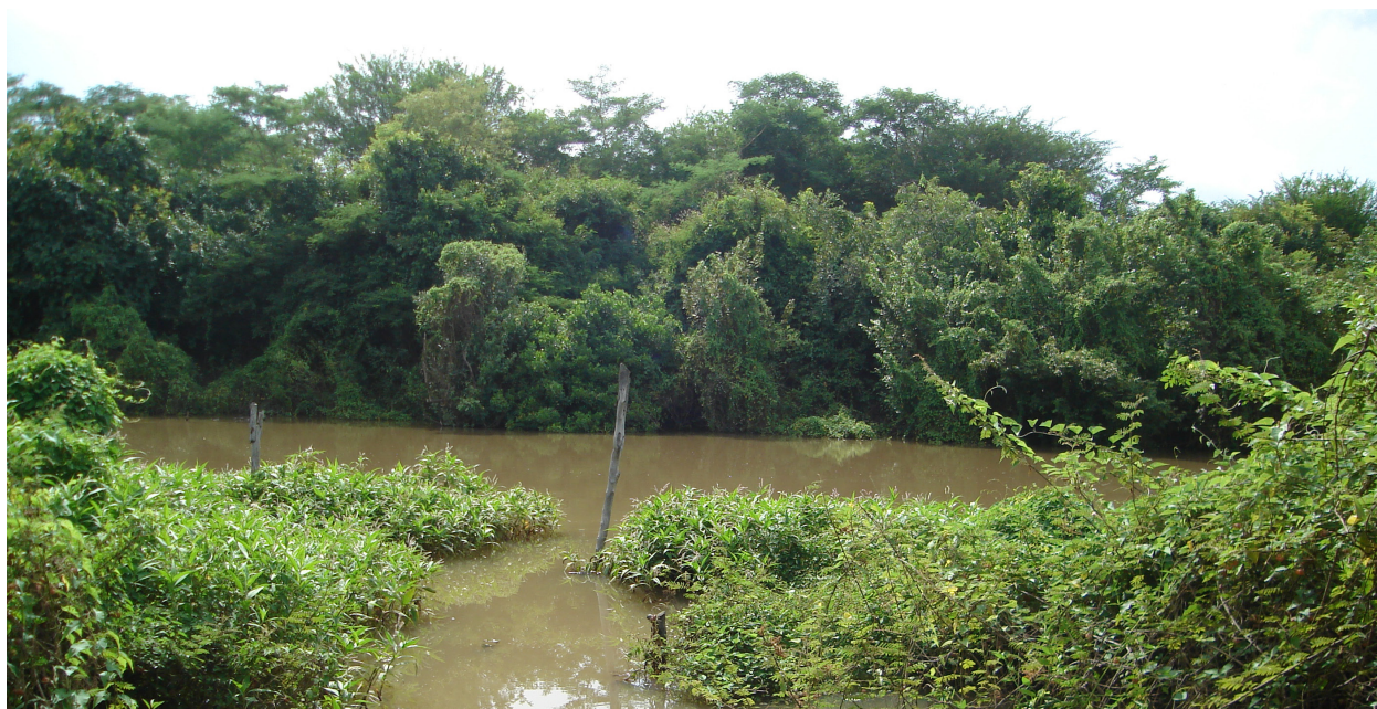
Protection de berge du fleuve du Mouhoun avec de la végétation naturelle (Source CPP)
