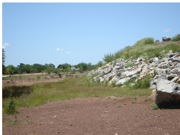
Protection des berges du Mouhoun par du perré sec non maçonné (Source CPP)
