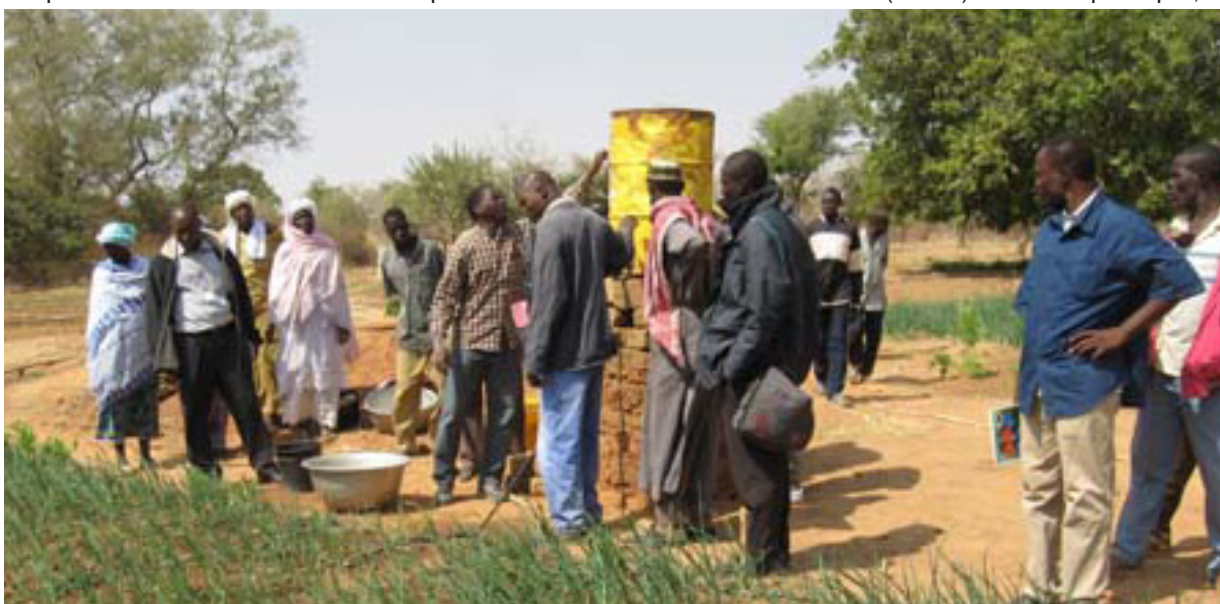
Mise en place d'une irrigation goutte-à-goutte en milieu rural (Source : Coopération Suisse)
