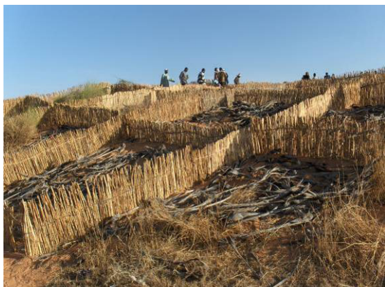
Fixation de dune avec des palissades (site 2008 du village de Selbo / province du Séno)
