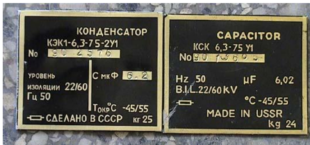
Снимка 5: Фабрична табела на руски кондензатори, съдържащи РСВ, експлоатирани в България
