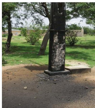
Photo n°12 : Stockage de transformateur à l'air libre dans l'Extrême Nord et sol contaminé au diélectrique
