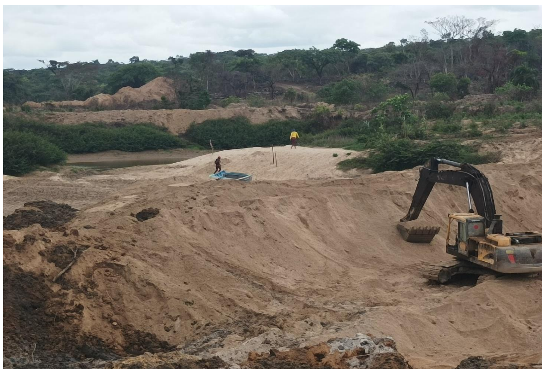
Figure 14: Déviation du lit du cours d'eau Lom à YASSA par BINDIBA, (Photo MINMIDT, 2023)
