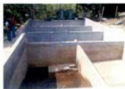
Fig 9. Estructura de concreto.
