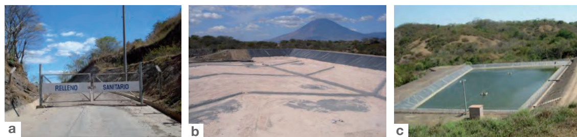
FIGURA 4. Fotografías de ejemplo de infraestructura básica de rellenos sanitarios
