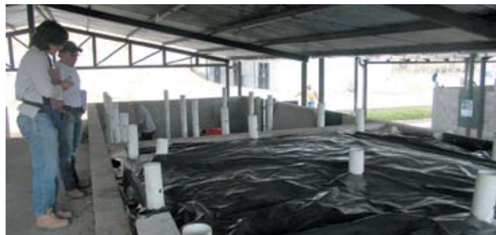
Planta de reciclaje y compostaje.
