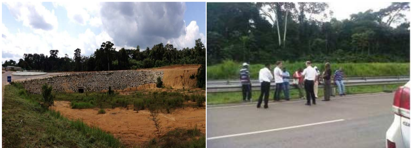
Figura 29. Visitas del equipo del PANA durante la misión de evaluación de la vulnerabilidad en la Región Continental de Guinea Ecuatorial durante el proceso del PANA. A la izquierda se muestra una obra de protección a la carretera a la entrada de Mongomo, y a la derecha el equipo PANA intercambia sobre los posibles impactos ambientales la zona en Oyala (Wele Nzas) (Fuente: Braby 2013, el proceso de elaboración del PANA).
