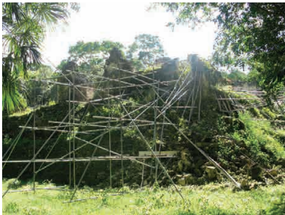
FIGURA 99. INTERVENCIÓN EN LA ESQUINA NE DE LA ESTRUCTURA A-5 DE UAXACTÚN EN 2009
