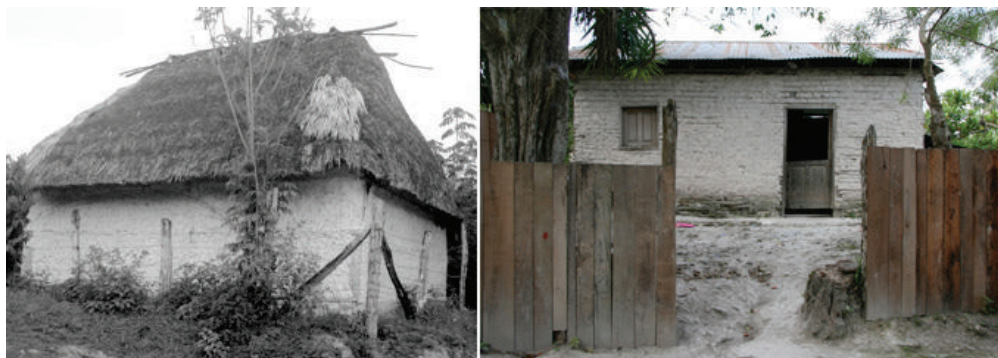
FIGURA 66. VIVIENDAS DE ESTILO MAYA PETENERO EN UAXACTÚN
