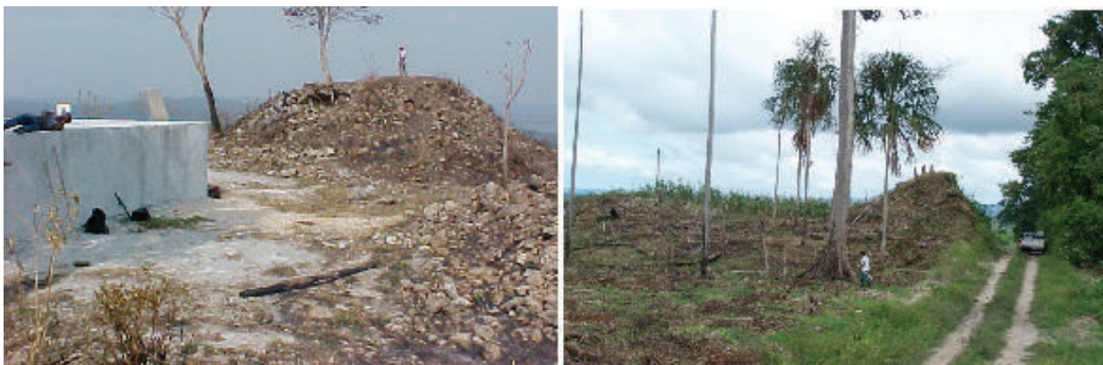
FIGURA 94. CONSTRUCCIÓN DE UNA CISTERNA EN EL SITIO DE LA GLORIA Y DESTRUCCIÓN DE UN MONTÍCULO POR UN CAMINO EN PROPIEDAD PRIVADA, SITIO HUACUTAL
