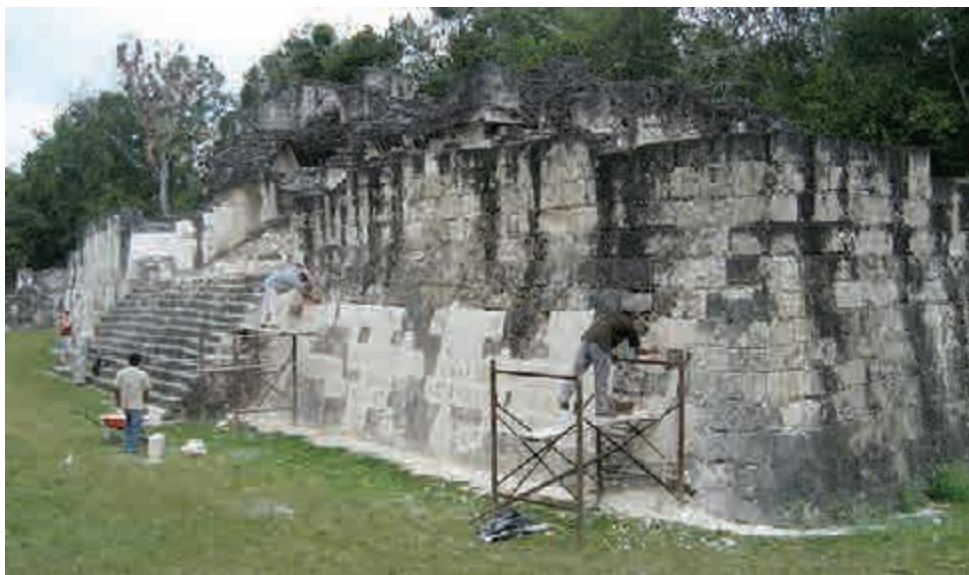
FIGURA 100. RESANADO DE LA RESTAURACIÓN DE LA ESTRUCTURA 5D-43, ACRÓPOLIS CENTRAL, TIKAL EN 2008
