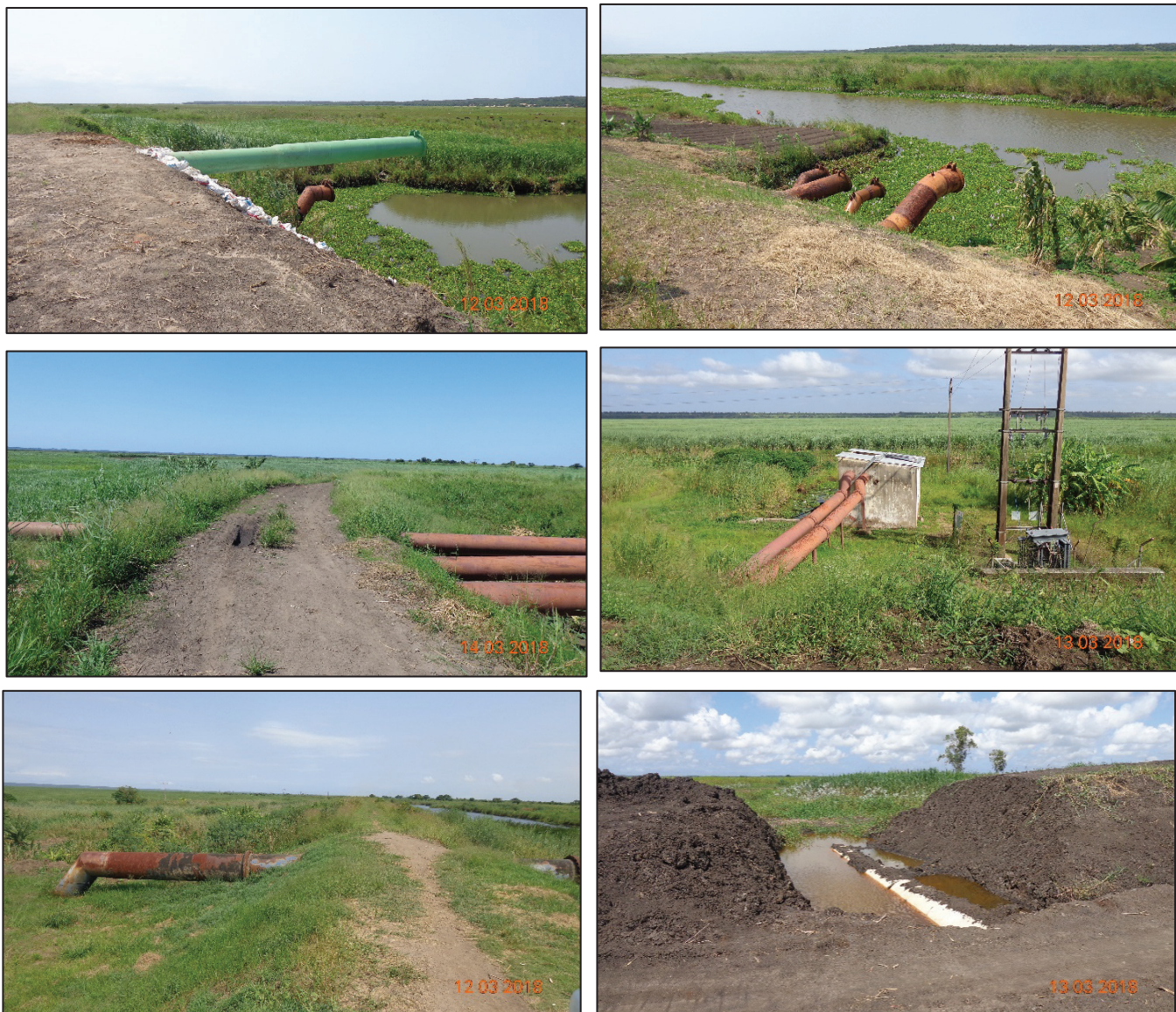
Figura 6-10d: Exemplos de tubos que atravessam diques
