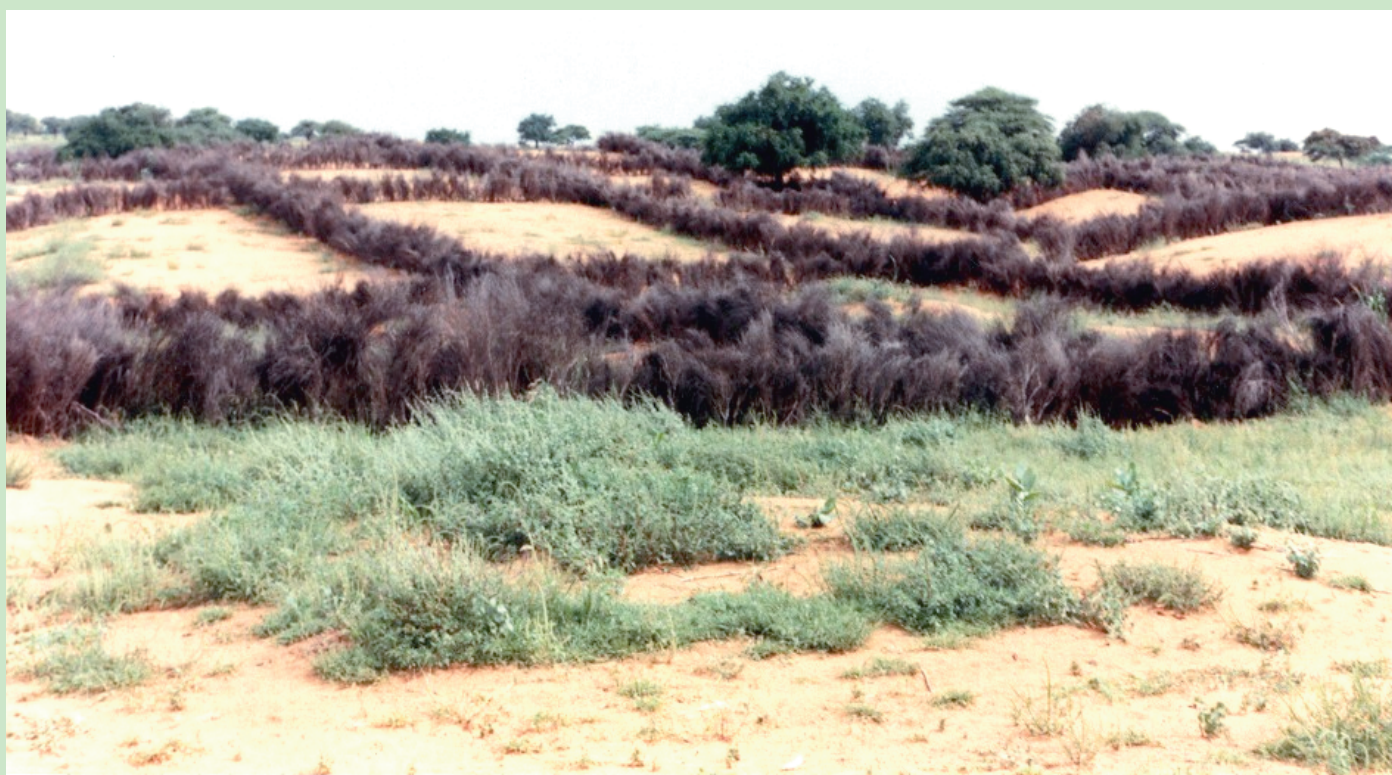
Lutte contre l'ensablement (fixation de dune) dans le bassin du fleuve Niger
