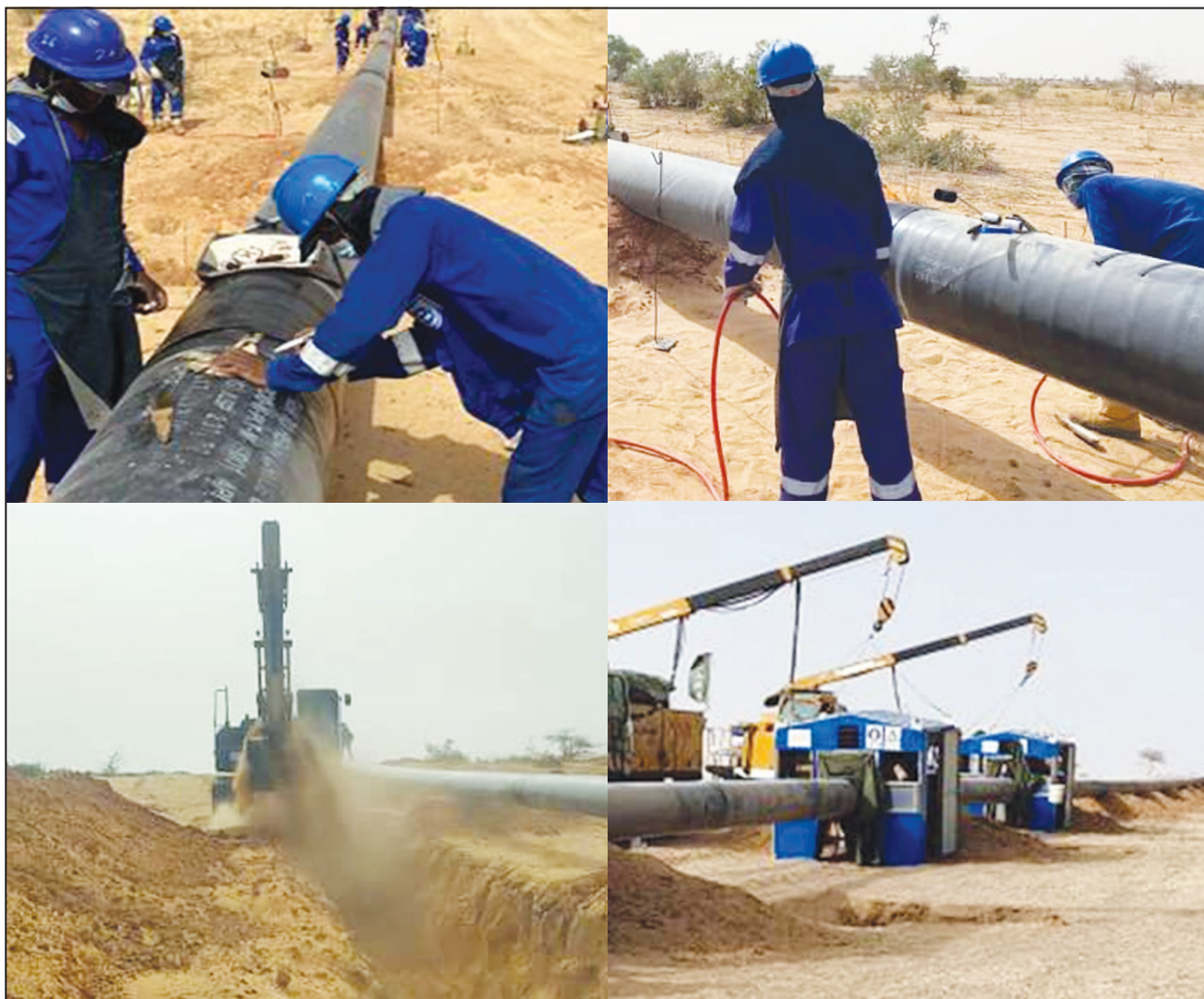
Pipeline Niger-Bénin en construction
