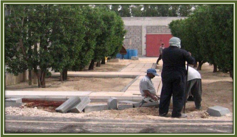
Construcción de una Instalación Ecoturística
