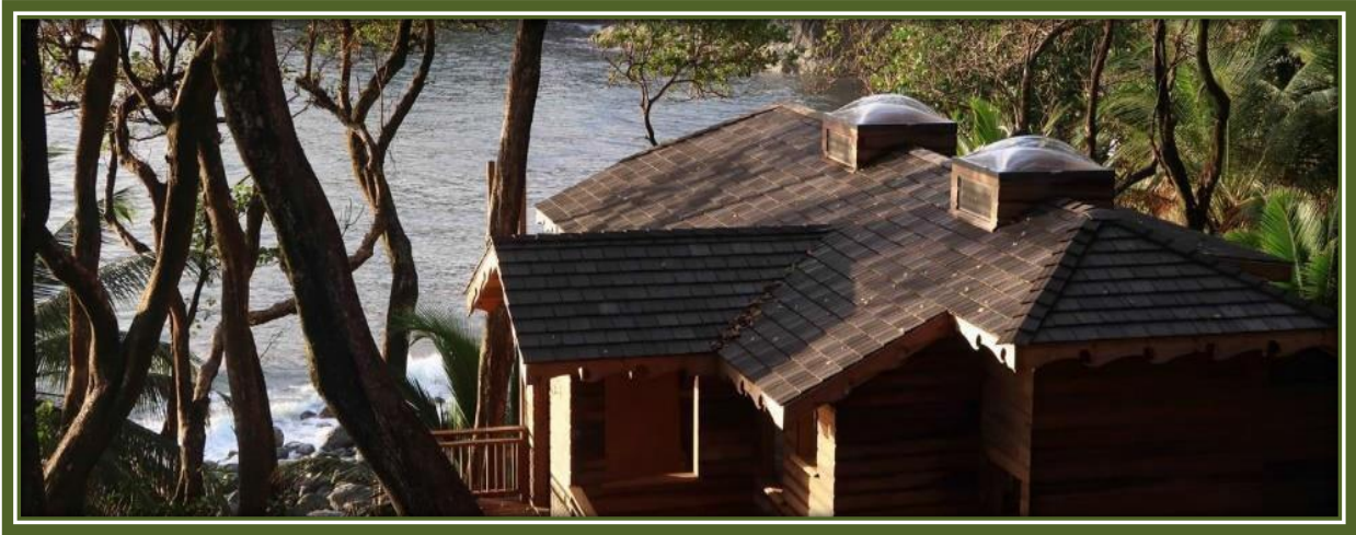
Luces de techo con persianas fijas ayudan con el enfriamiento por convección de aire
