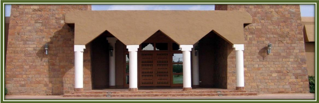
Esta instalación ecoturística se construyó utilizando pacas de paja y piedra.
