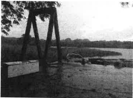
Puerto Posada, estructura de pesa histórica
