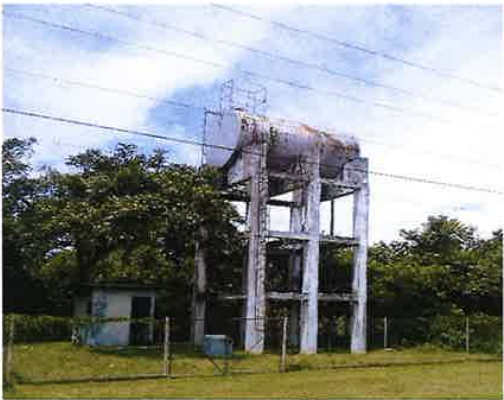
Fotografía 4.9. Tanque de agua, comunidad de Las Guabas. 2019.
