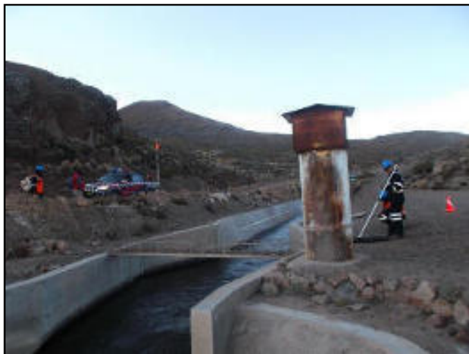
Fotografía N° 38 Estación Huaylillas, caseta limnigráfica.
