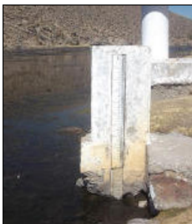
Fotografía N° 28 Regla Limnimetrica estación Chuapalca
