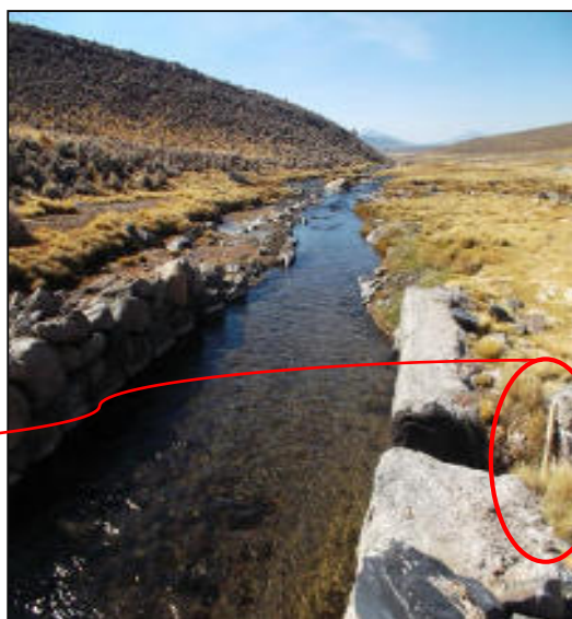
Fotografía N° 23 Muros de la estación Kovire Bojedal
