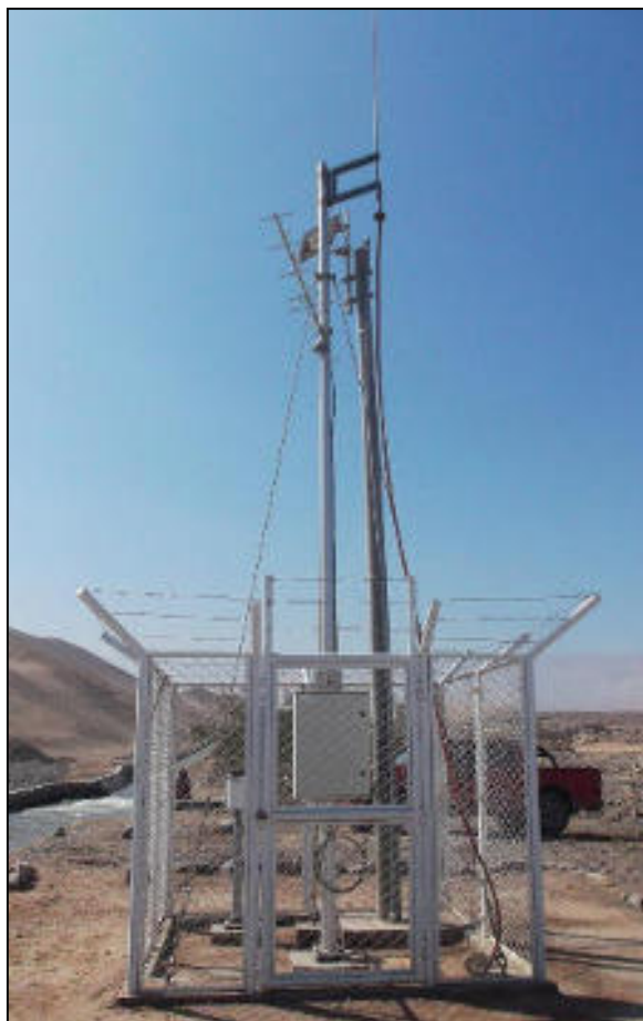
Fotografía N° 52 Estación Piedra Blanca
