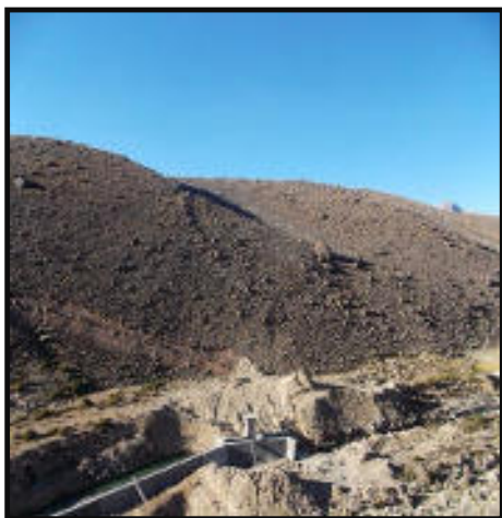
Fotografía N° 3 Estación hidrométrica Paucarani
