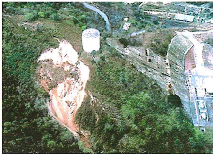
Tanque de almacenamiento en zona de deslizamiento.
