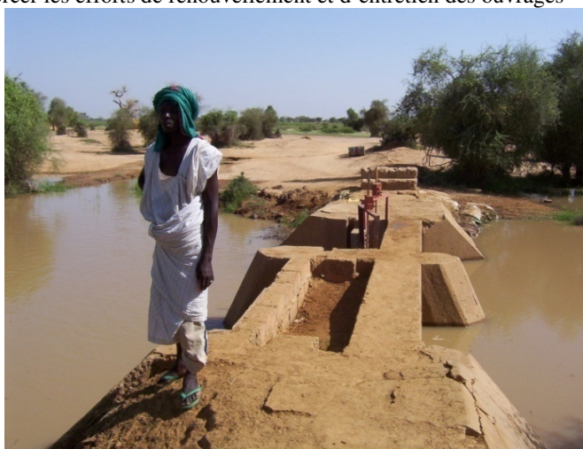
Photo 4 : Ouvrage hydraulique (© Gora Ndiaye)
