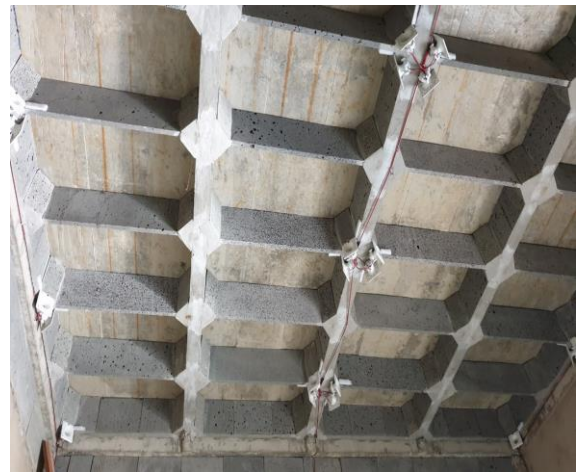
Hình 15. Lắp đặt thanh giá tổ trong nhà yền (lam gỗ và lam đá) (Nguồn: Võ Tấn Phong)
