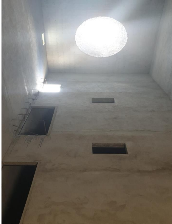
Hình 12. Thông tầng thẳng trong nhà yến (Nguồn: Võ Tấn Phong)
